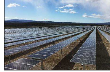
Parc solaire – 12.0 MWc Lanas (07) Foncier départemental → Développement, Financement, Construction et Exploitation Délaissé aéroportuaire
