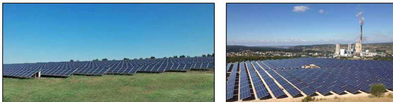
Réalisations Urbasolar : à gauche, Granitec en Bulgarie / à droite, aménagement d'un ancien terroir à Gardanne (13)
