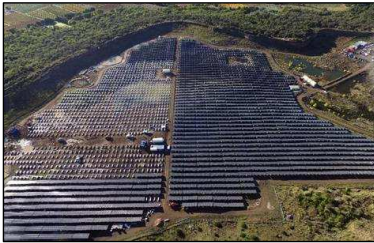
Parc solaire – 7.4 MWc Moussoulens (11) Foncier communal → Développement, Financement, Construction et Exploitation Ancien aérodrome
