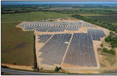
Parc solaire avec trackers – 12.0 MWc Arles (13) Foncier privé → Développement, Financement, Construction et Exploitation Ancienne carrière
