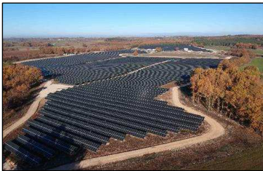
Parc solaire – 11.5 MWc Faux (24) Foncier communal → Développement, Financement, Construction et Exploitation Anciens circuit automobile et ball-trap, pollués au plomb
