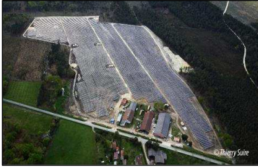
Parc solaire avec trackers – 8.8 MWc Sos (47) Foncier intercommunal → Développement, Financement, Construction et Exploitation Site BASOL
