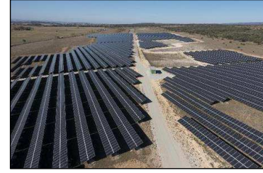
Parc solaire – 11.5 MWc Nizas & Lezignan la Cèbe (34) Foncier communal → Développement, Financement, Construction et Exploitation Ancienne carrière
